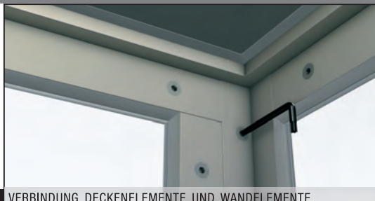
8 VERBINDUNG DECKENELEMENTE UND WANDELEMENTE
